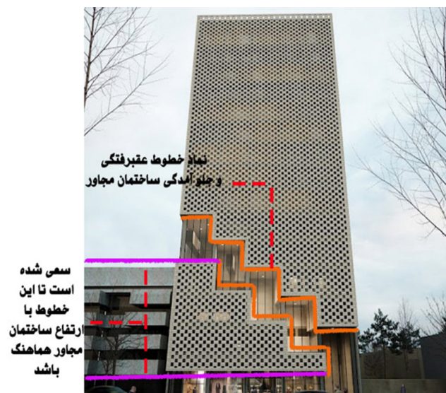
شکل ۷: هماهنگی ساختمان پلاسکو با خطوط پاسازکویته‌ها
